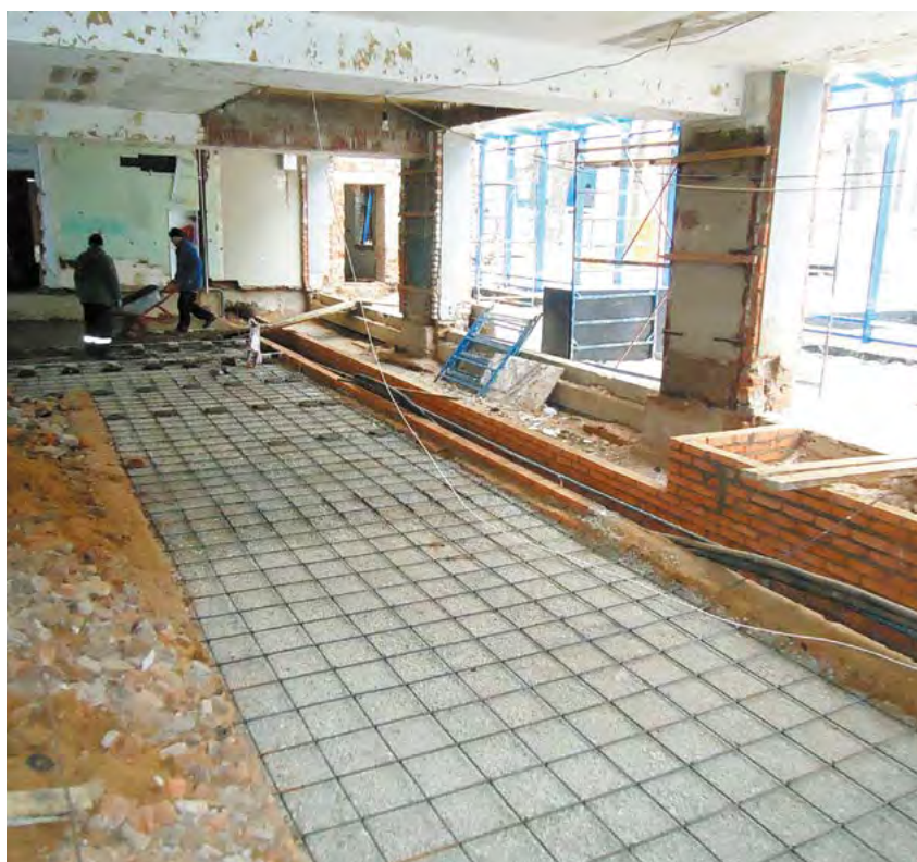
Стадия строительных работ по состоянию на 18.11.2016 г. (пристройка галереи, заливка полов)
