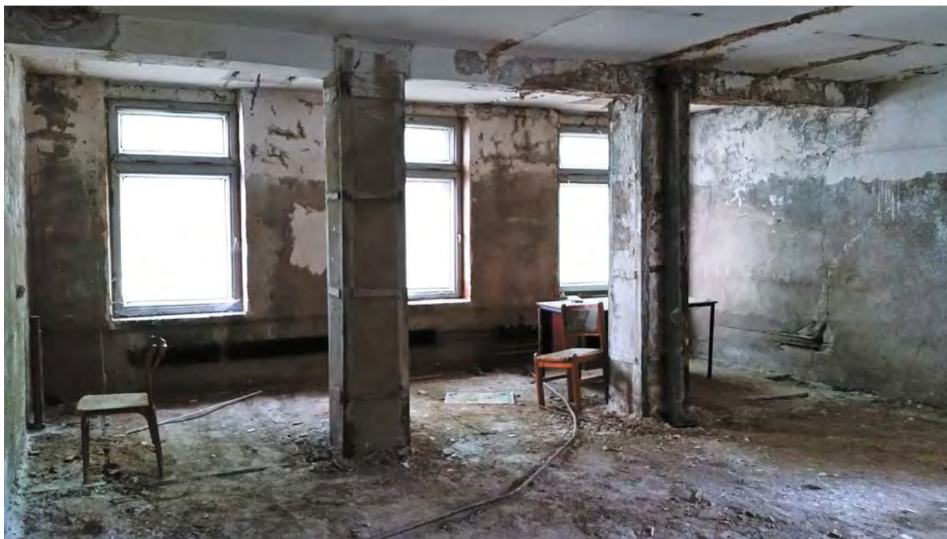
Подготовка помещения под «Зал технологий»
