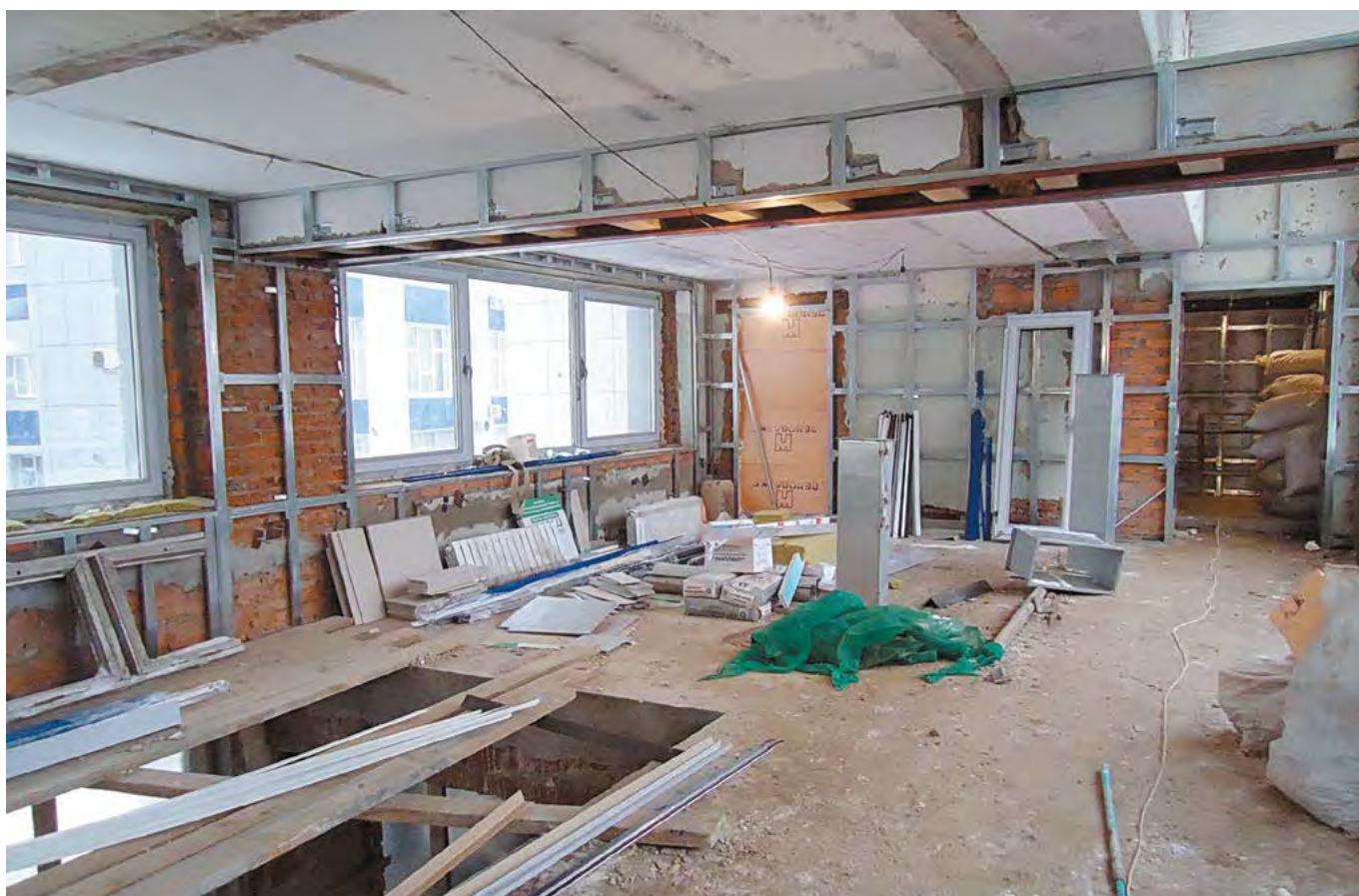
Стадия строительных работ по состоянию на 27.12.2016 г. (2 этаж, после выемки плит перекрытия)
