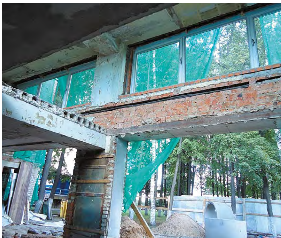
Стадия строительных работ по состоянию на 01.09.2016 г. (вскрытие перекрытий и проводка коммуникаций)
