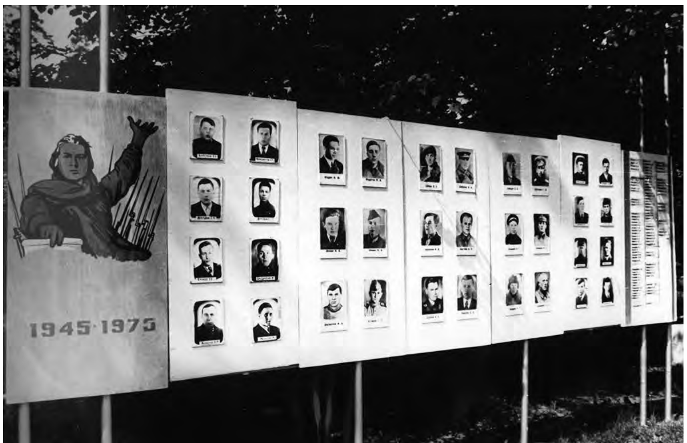
Стенд на территории городского парка, подготовленный при участии и по материалам музея завода, 1970-е гг.
